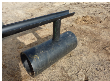
Teknikkasse med blæser og ventilsystem til udsugning og indblæsning. Rørene, som de er, indstøbt i bunden af komposteringsmåtten.
