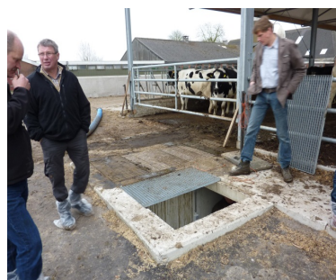
Blæsere og fordelingsrør er placeret i en underjordisk gang langs den ene gavl. Nedgang til underjordisk gang med indblæsningsudstyr.
