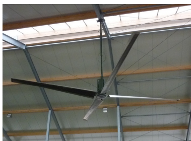
Vandret ventilator propel i loftet. Der var 3 stk. i den 100 meter lange stald.
